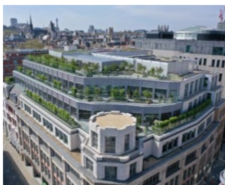
Northcliffe House, London, Großbritannien, Bürogebäude
