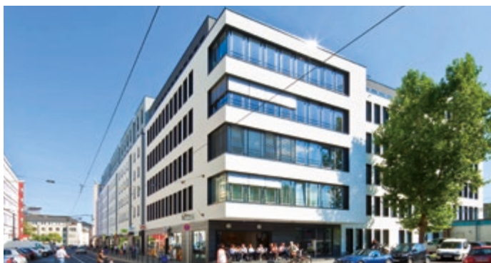
Hedderichstraße, Frankfurt/Main, Deutschland, Büro-, Wohn- und Geschäftsgebäude
