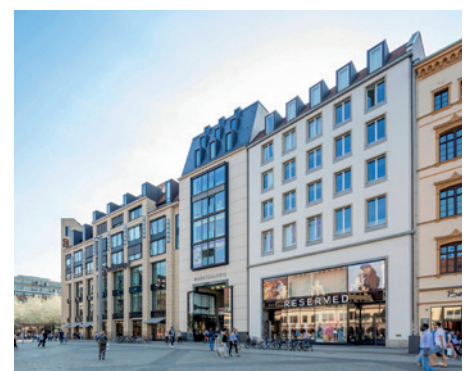
Marktgalerie, Leipzig, Deutschland, Büro-, Wohn- und Geschäftsgebäude
